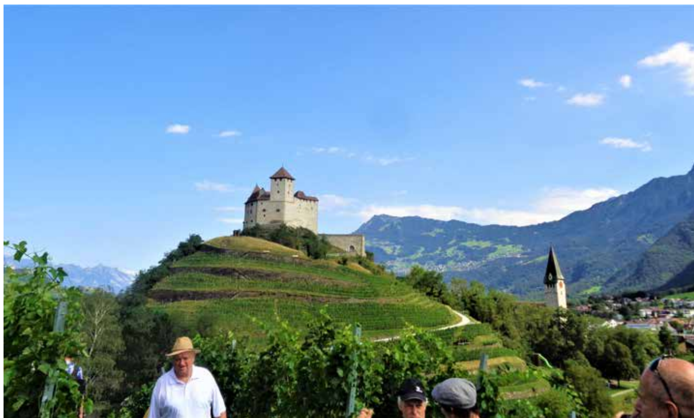
Obr. 21: Nově zbudované terasy a hrad Gutenberg
