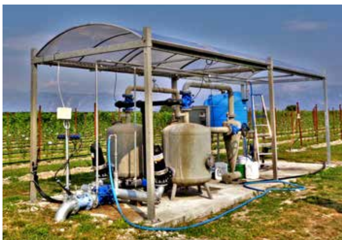
Obr. 9: Centrální dávkování hnojiv do vody
